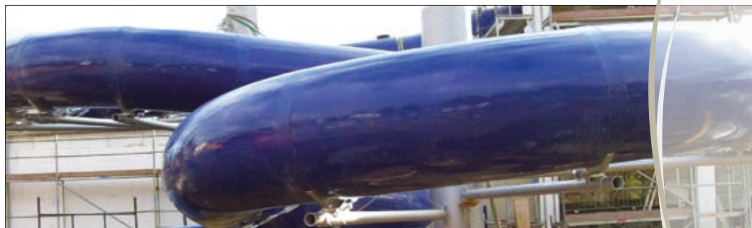
Zjeżdżalnia z dociepleniem w trakcie montażu – druga powłoka jest pozbawiona szwów
