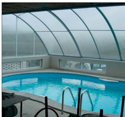
Zadaszenie oparte o ścianę budynku
